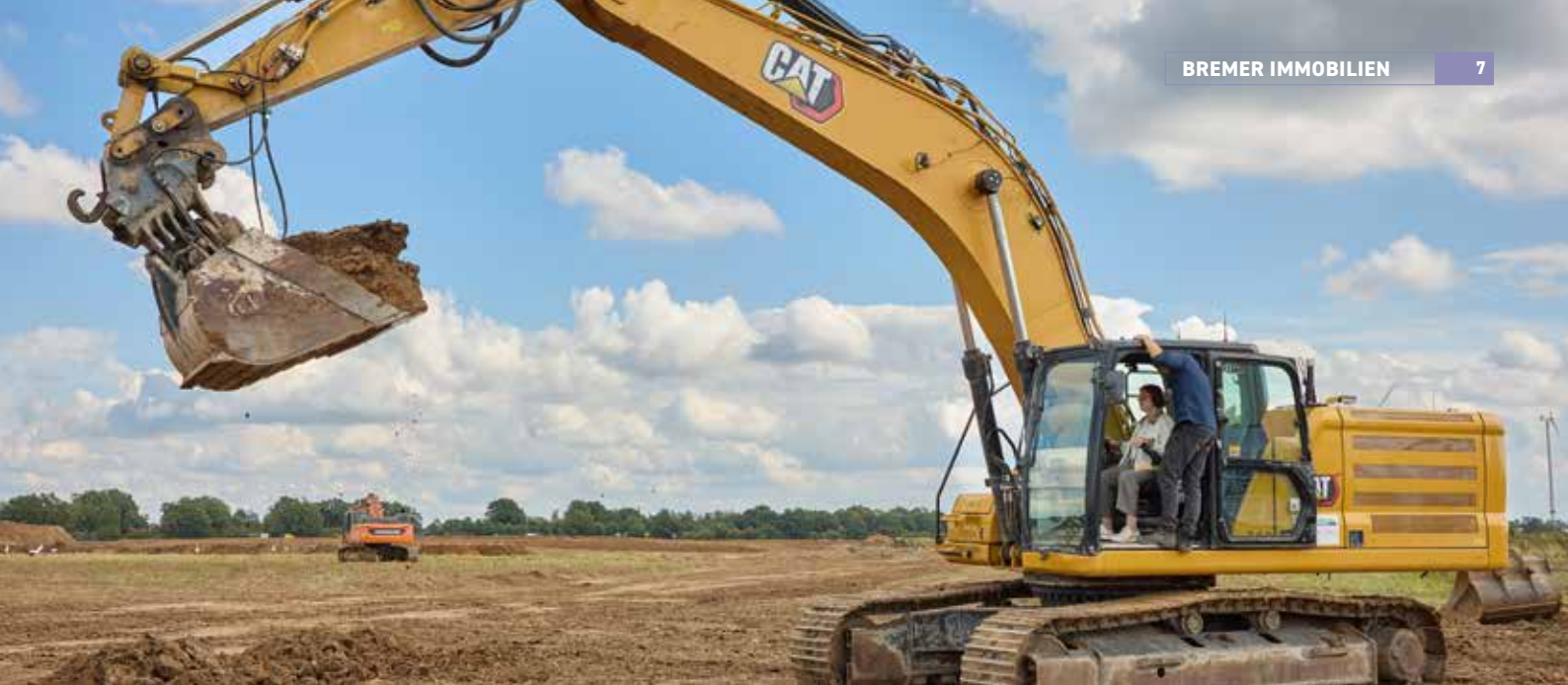
Im Gewerbegebiet Hansalinie hat die WFB mit den Arbeiten für den dritten Bauabschnitt begonnen.
