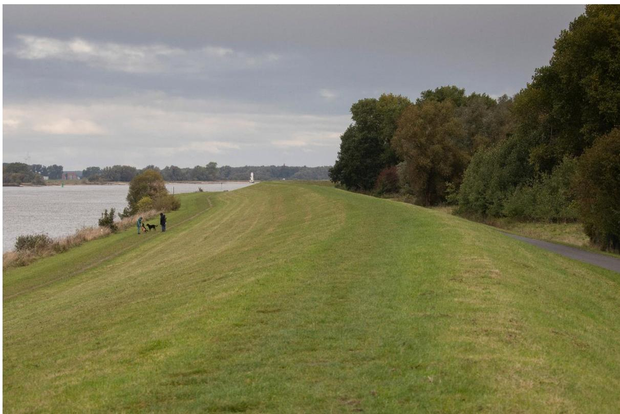
Deiche bestehen im Kern aus einem großen Sandwall, der an der Oberfläche mit einer Kleischicht abgedichtet und zusätzlich mit einer Schutzschicht aus Gras befestigt ist. Neben buddelnden Hunden verursachen Bisame und Nutrias die schwersten Schäden. ©WFB/Jörg Sarbach
