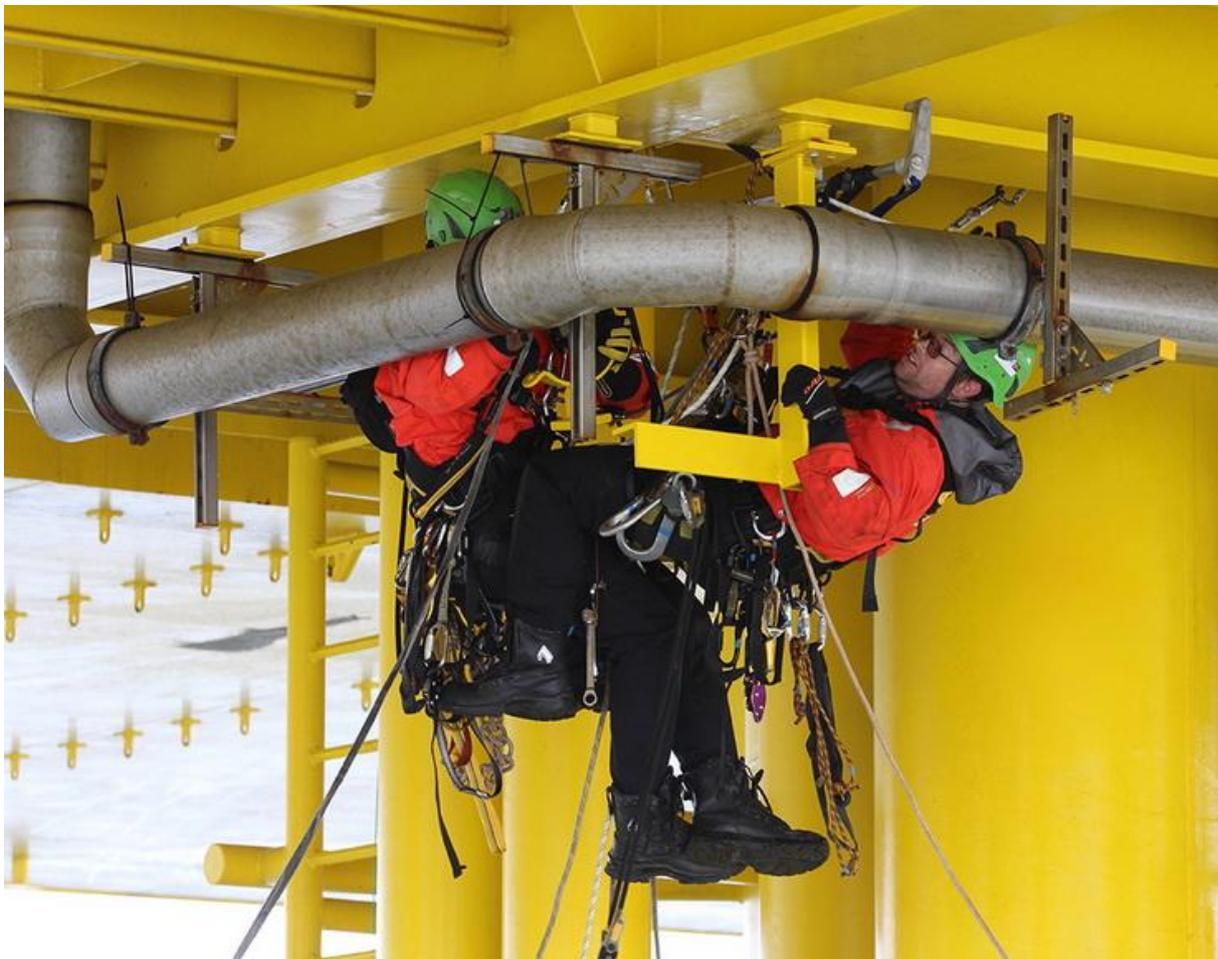
Industriekletterer bei der Installation einer Regenwasserleitung beim Offshore Windpark „Baltic 2“ in der Ostsee © mh<sup>2</sup> Offshore GmbH
