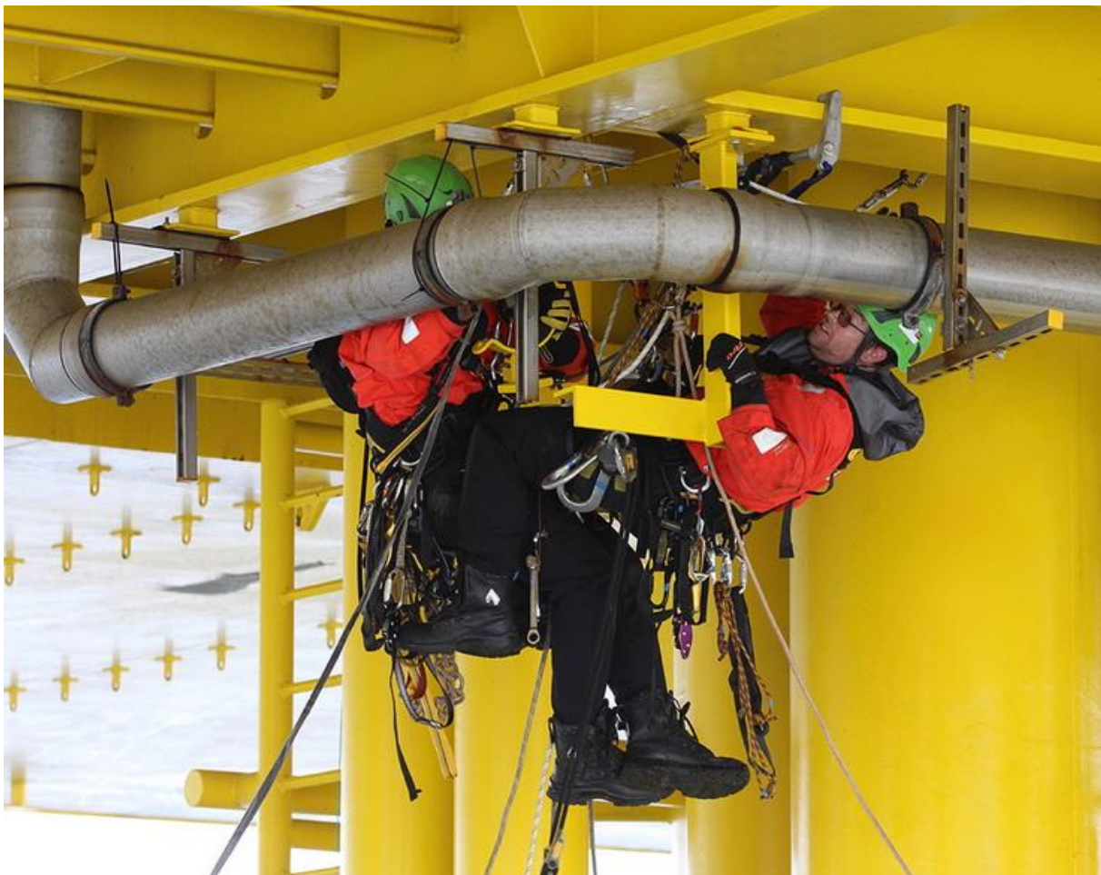
Industriekletterer bei der Installation einer Regenwasserleitung beim Offshore Windpark „Baltic 2“ in der Ostsee © mh 2 Offshore GmbH
