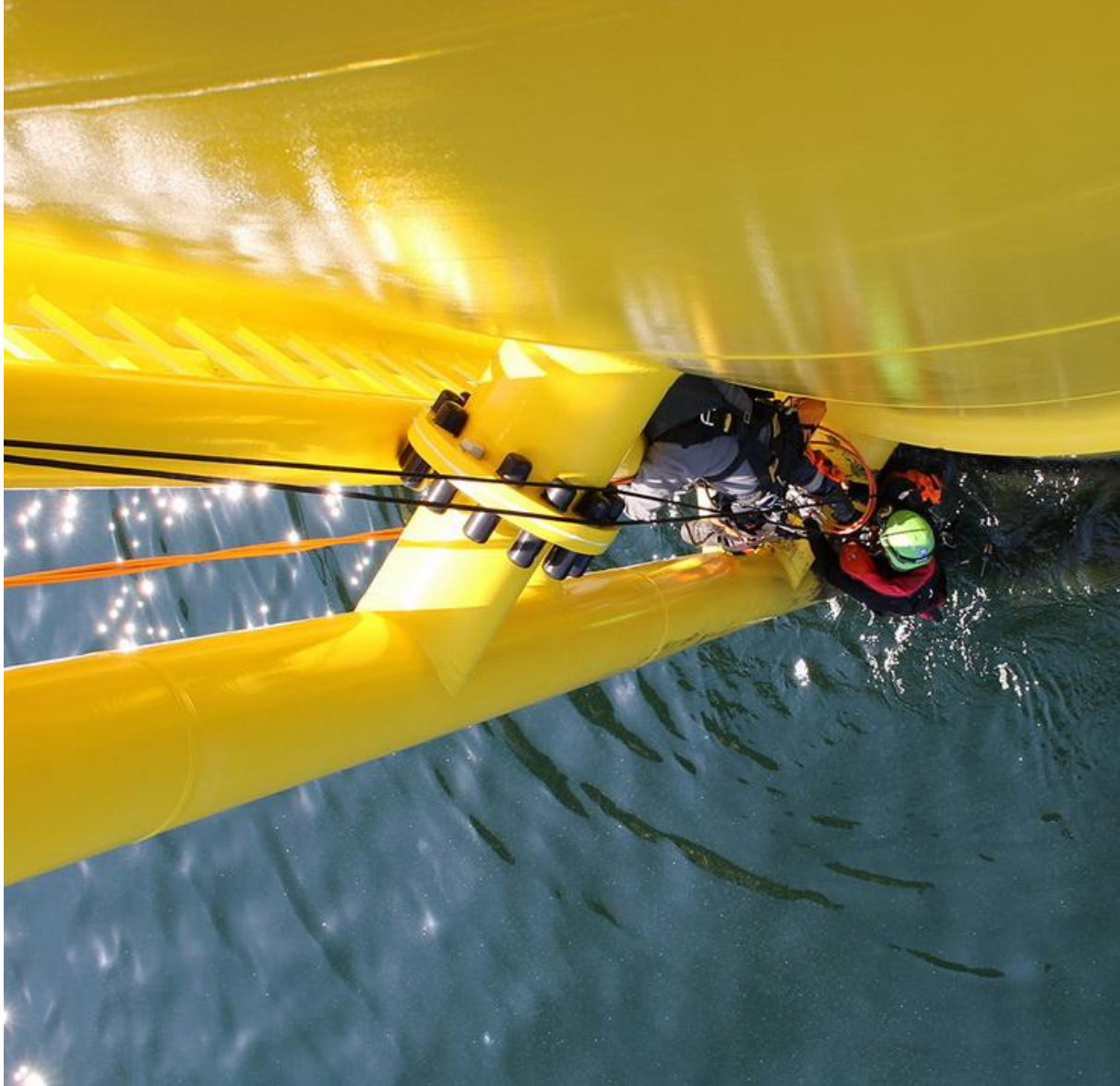
Industriekletterer bei der wiederkehrenden Prüfung und Inspektion der Seilzugangstechnik beim Offshore-Windpark „Amrumbank West“ ©mh 2 offshore GmbH
