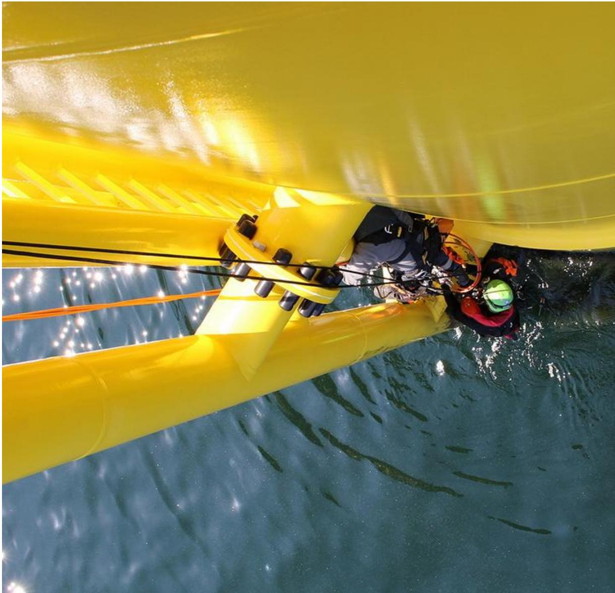
Industriekletterer bei der wiederkehrenden Prüfung und Inspektion der Seilzugangstechnik beim Offshore-Windpark „Amrumbank West“ ©mh<sup>2</sup> offshore GmbH
