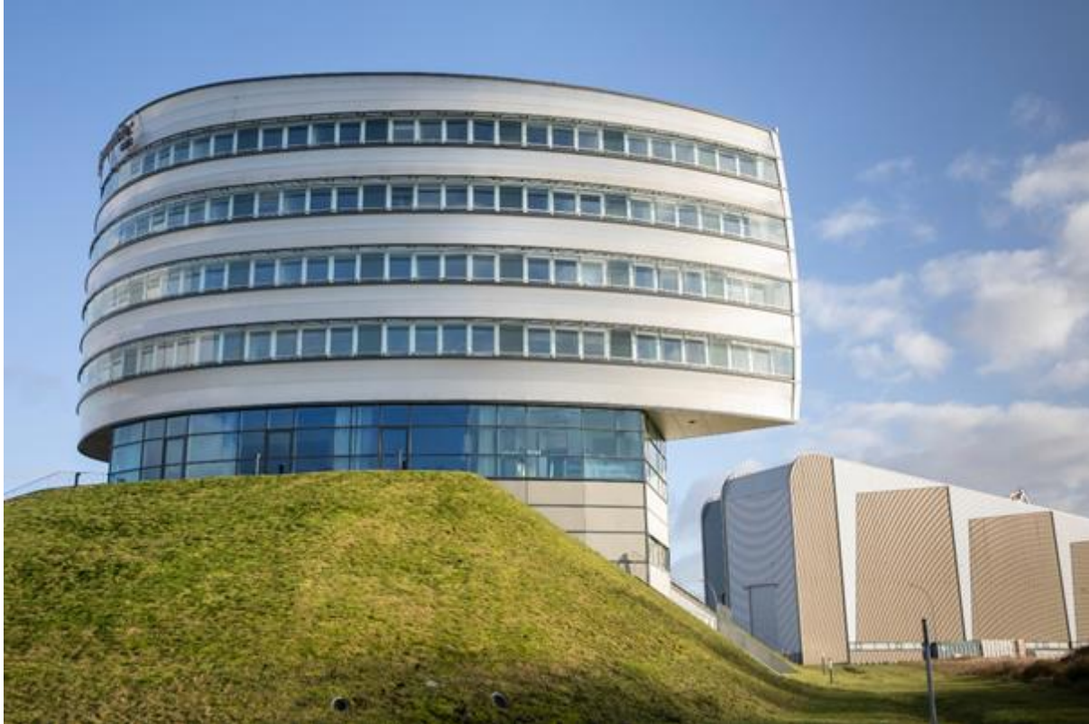
Im Vordergrund ist das Bürogebäude des IWES zu sehen. Im Hintergrund befindet sich die Halle, in der Blattprüfstände stehen. Ein neuer IWES-Prüfstand für Blätter mit einer Länge von 120 Metern ist gerade in Planung. © WFB/Jörg Sarbach
