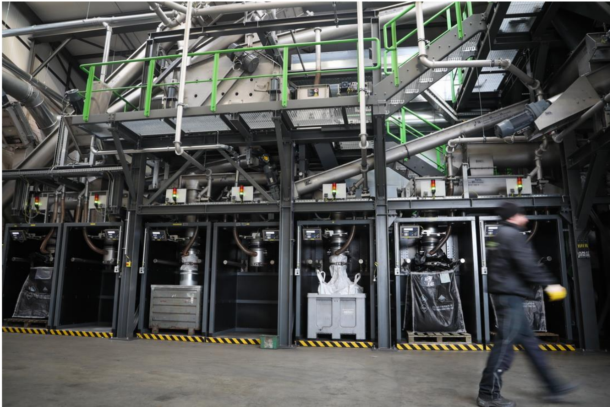
Die neue Anlage in Bremerhaven kann sogar Lithium-Batterien recyceln. © WFB/Focke Strangmann
