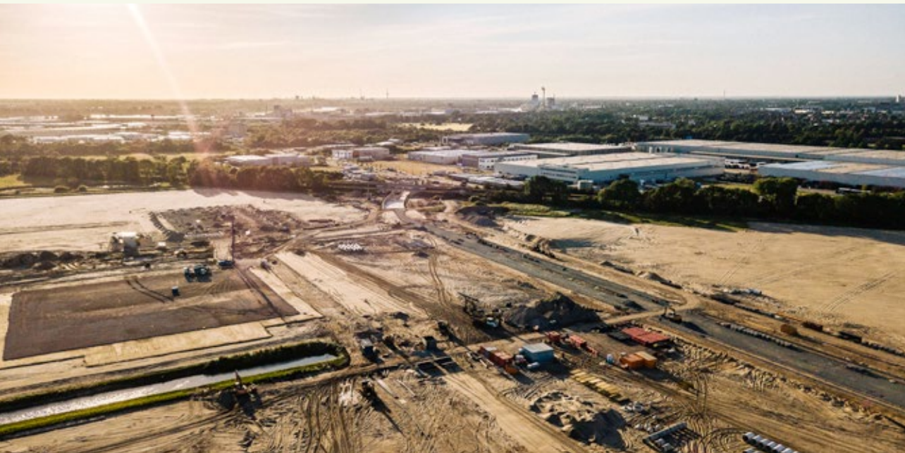
Erschließung des zweiten Bauabschnitts im Gewerbepark Hansalinie
