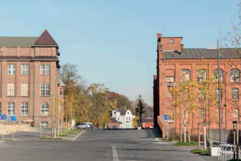
Historische Gebäudesubstanz mit Architektur der Gründerzeit
