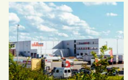
Uhlhorn, GVZ Güterverkehrszentrum Bremen
